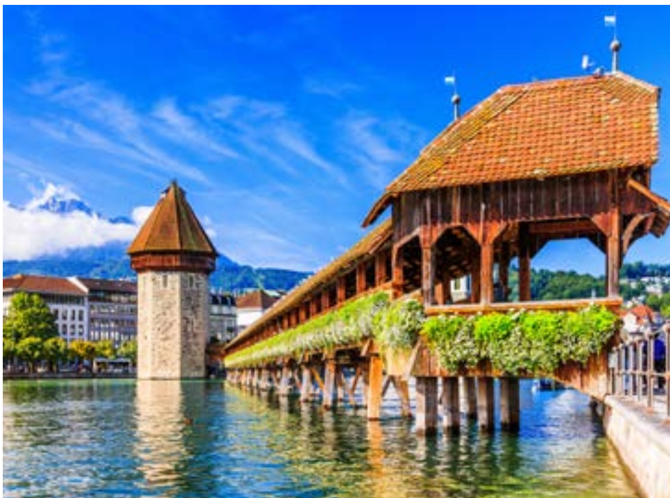
Kapellbrücke in Luzern
